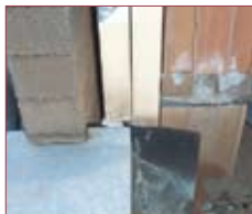
buitenmuur (2 x 4 cm PUR-isolatie) + verlijmd isolerend metselwerk
