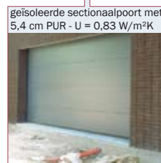
geïsoleerde sectionaalpoort met 5,4 cm PUR - U = 0,83 W/m²K
