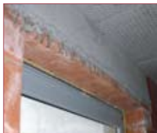
venster met ventilatierooster, U = 1,78 W/m 2 K
