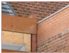
muur naar buur = 14 cm metselwerk + muur in houtskelet met 12 cm glaswol
