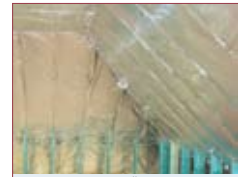
zolder is extra geïsoleerd met 15 cm glaswol om warmteverliezen te beperken
