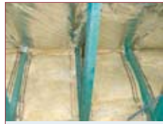
plafond van eerste verdieping naar zolder met houten balken en 12 cm glaswol
