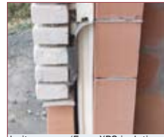
buitenmuur (5 cm XPS-isolatie + isolerend metselwerk)
