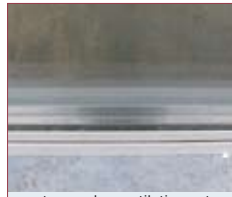
venster zonder ventilatierooster: U = 1,59 \text{ W/m}^2\text{K}
