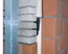
aansluiting spouwisolatie met isolatie gemene muur
