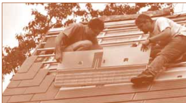
Integratie van PV-shingle tussen vezelcementeien (Soltech, Eternit)
