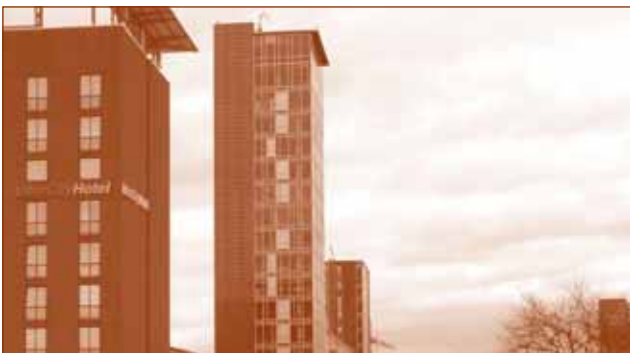
PV-modules als renovatie van de gevel van een kantooortoren in Freiburg (Duitsland)
