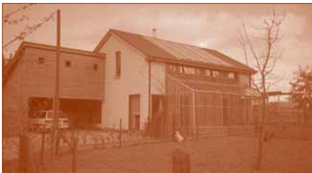
Dakgeïntegreerd PV-systeem van 3,4 kWp op dak in tegelpannen te Moorsel (arch. Eeckhout en Van den Broecke, Gent)
