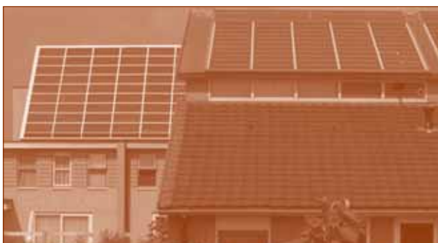
Twee PV-daken uit het 1 MWp-project 'Nieuwland' bij Amersfoort (NL); vooraan rechts PV-modules met bovenaan thermische collectoren, achteraan een prefab dakelement met PV-modules (Novem)
