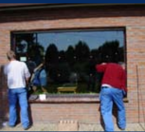
Vervanging van enkel glas door hoogrendementsglas.
